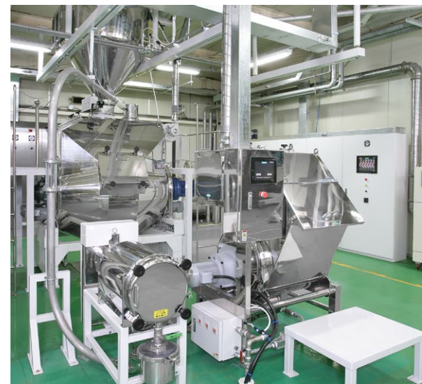
5.副原料切込み及び輸送設備
