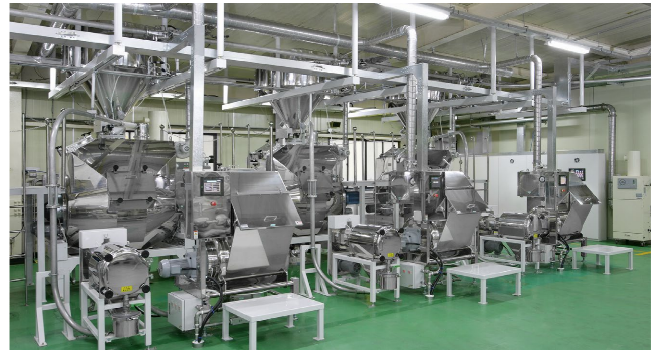
4.副原料切込み及びミキサー設備
